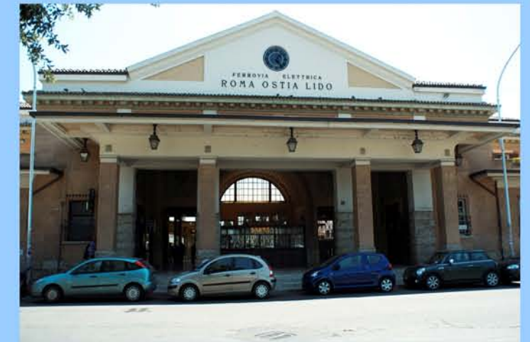
Stazione della ferrovia Roma - Lido
