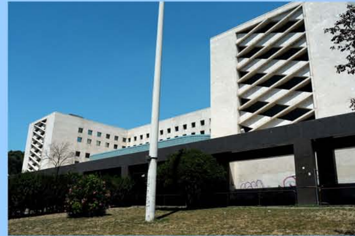
Palazzo delle Poste in via Marmorata
