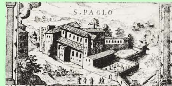
La basilica di San Paolo nella Pianta di Roma di G. Maggi del 1600; sono evidenti alcune delle fortificazioni riferibili alla Giovannipoli
