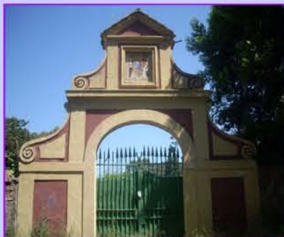
Il portale della proprietà Nicolai posto lungo via delle Sette Chiese, n° 139.
