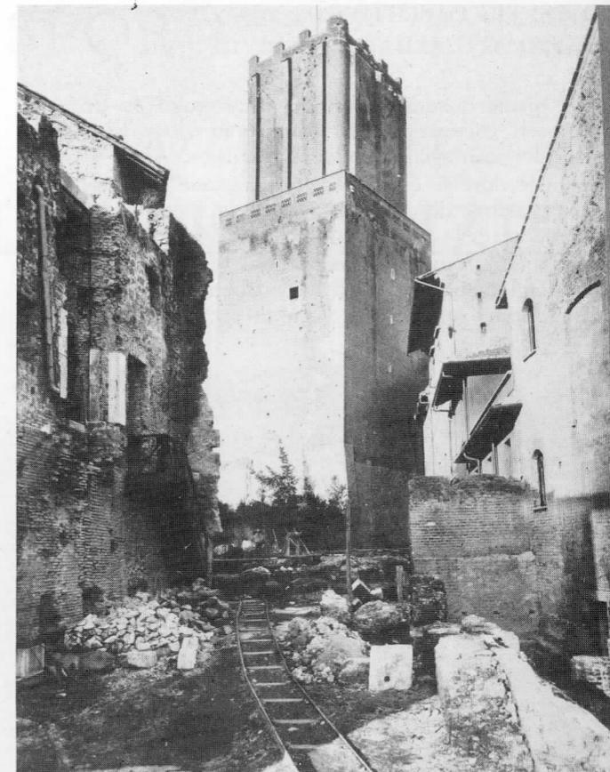
Fig. 3 - La torre alla conclusione dei lavori di isolamento. Nella parte basamentale sono visibili le tracce dei restauri (Archivio Fotografico Comunale).
