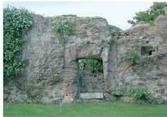
Fig. 18. Roma, Colle Celio: particolare della struttura laterizia addossata ai piloni dell'acqua Claudia all'interno del giardino dei Padri Passionisti, vista da nord est.
