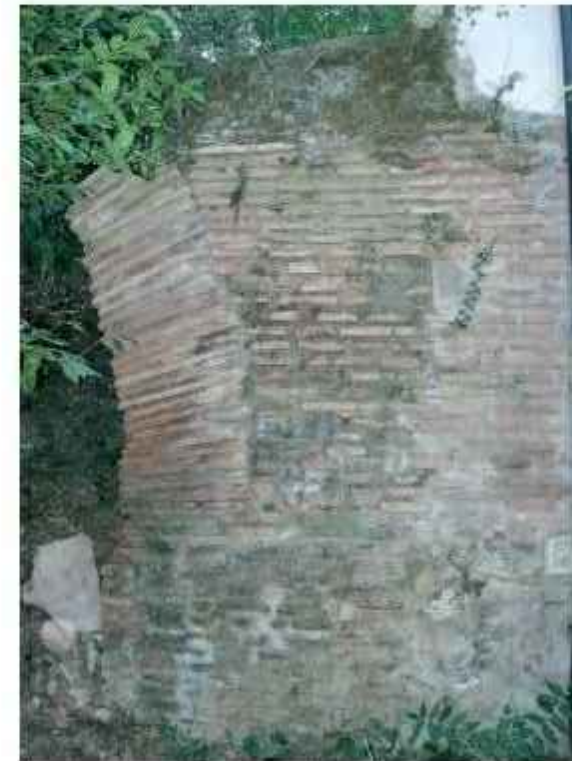
Fig. 14. Piloni con arco laterizio alle spalle della "Casina del Salvi", visto da nord.
