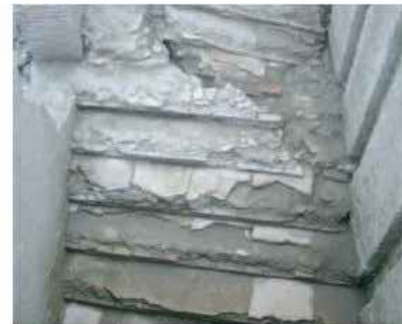
Fig. 6. Roma, Colle Celio, "Casina del Salvi": particolare delle fondazioni in conglomerato cementizio, viste da nord ovest.
