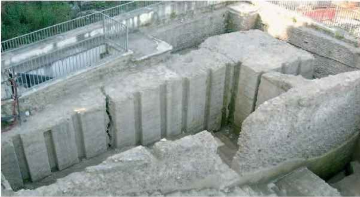
Fig. 8. Roma, Colle Celio, "Casina del Salvi": le fondazioni e il pilone in conglomerato cementizio, visti da nord.
