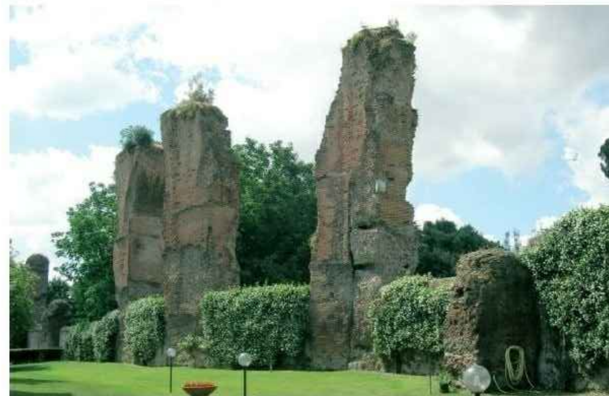
Fig. 16. Roma, Colle Celio: i piloni dell' acqua Claudia all'interno del giardino dei Padri Passionisti, visti da nord est.
