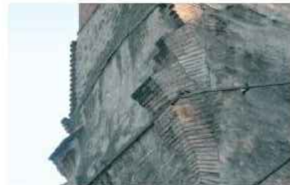
Fig. 13. L'imposta delle arcuazioni nel pilone di snodo a valle del Palatino.
