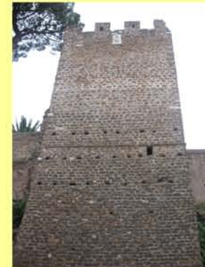
Torre restaurata da papa Niccolò V
