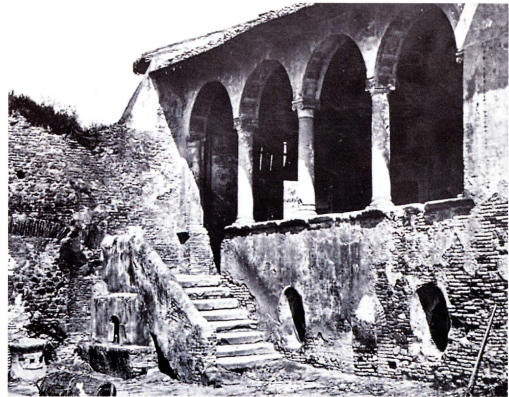
La Casina del Cardinal Bessarione prima del restauro
