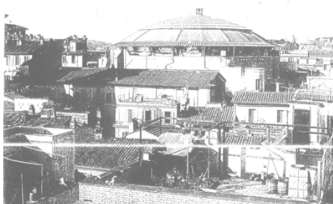
Il Mausoleo di Augusto e il tessuto edilizio circostante prima delle demolizioni
