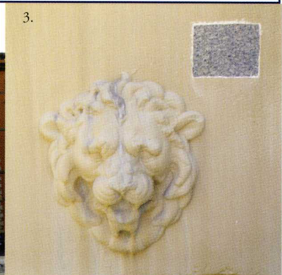
3. Fontana Nord-Ovest, vasca in granito: prove di pulitura
