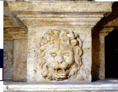
3 e 4. Particolare decorativo del prospetto prima e dopo il restauro.
