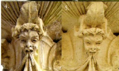
4 e 5. Fontana Nord-Ovest: il balaustro con mascherone e nastro prima e dopo il restauro
